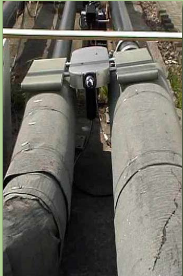
Technische Umsetzung der Anordnung zur Zustanderfassung nicht begehrbarer Kanäle einschließ- lich faser-optischer Messung zur temporären und per- manenten Leckageortung - Kanalspinne -
